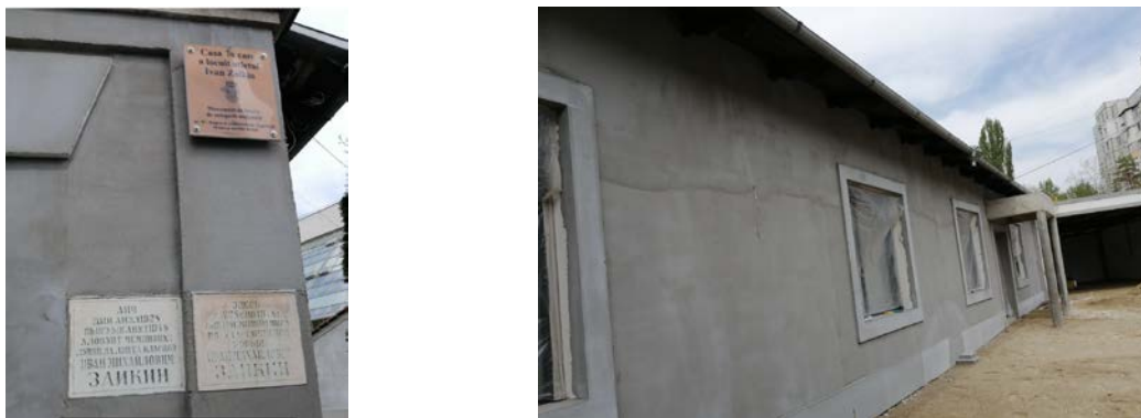
Figura 7. Casă în care a locuit atletul Ivan Zaikin (monument de arhitectură de importanță locală), edificată în primii ani a secolului XX. Starea curentă.
